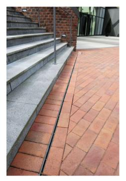
Les bords latéraux sont ajourés pour capter l'eau de la membrane drainante sous le stabilisé.
