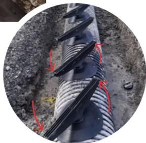
Insérer les grilles sur les tuyaux et les relier les unes aux autres grâce au système d'emboîtement mâle-femelle. Pour ce faire, il faut exercer un mouvement de rotation sur l'axe horizontal jusqu'à emboîtement complet et s'assurer du bon alignement des grilles.
