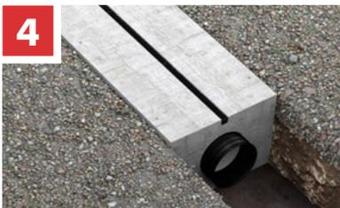
Remplir de béton la tranchée en recouvrant les tuyaux jusqu'au bord supérieur des grilles. La classe de résistance du béton devra répondre à la classe de charge demandée. Couler le béton par couches successives afin d'éviter le flottement de la conduite.
