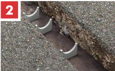
AXLDrain est fourni avec des supports en EPS. Les poser au fond de la tranchée d'excavation. La tranchée devra au préalable avoir été convenablement compactée et nivelée.
